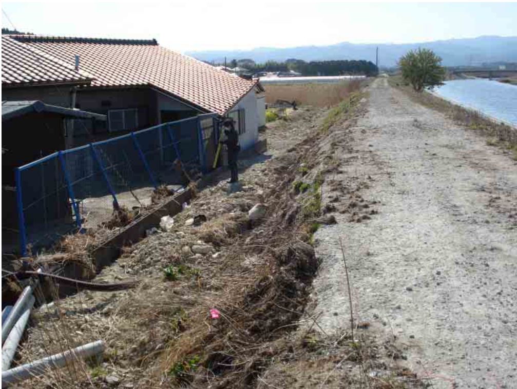
図-6 堤防の越水痕跡（蛭田川）
