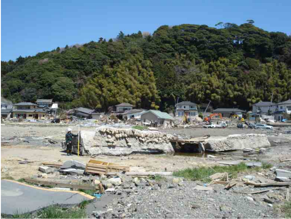
図-2b いわき市_鮫川河口右岸周辺地区（手前：破壊された海岸堤防、山際には流された家と被害の少ない家が混在、旧河道の地盤がやや低い箇所における被害が特に甚大）
