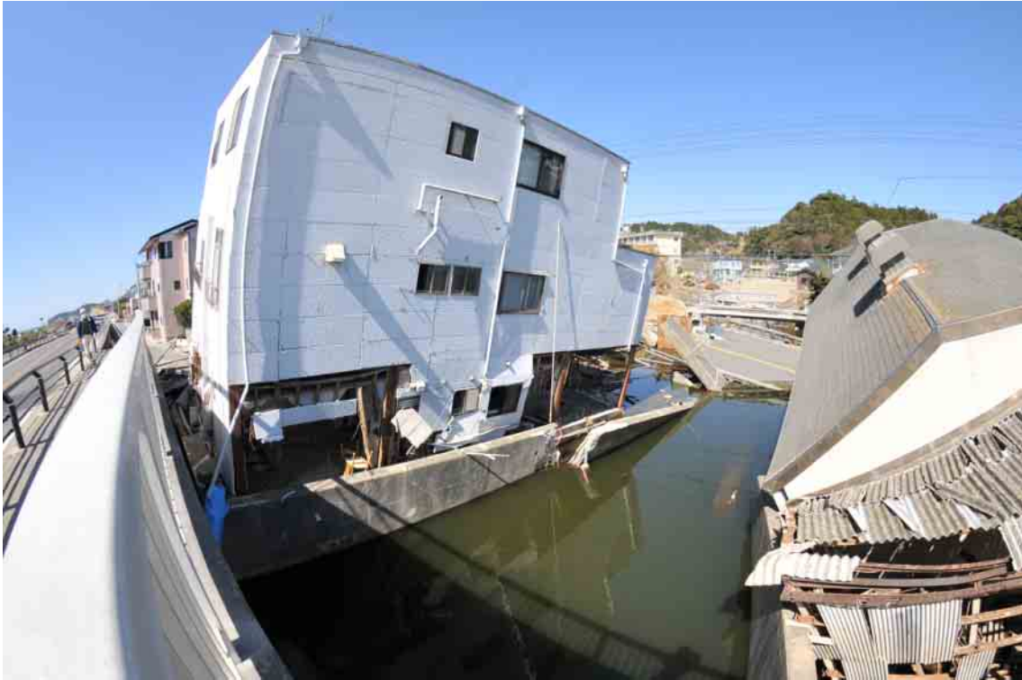
図-5 地震、液状化、津波の複合災害（大平川）：この写真のみ魚眼レンズで撮影
