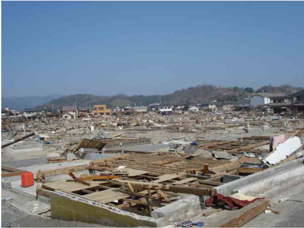
図-2a いわき市__大久川河口右岸周辺（海側から陸側を臨む）
