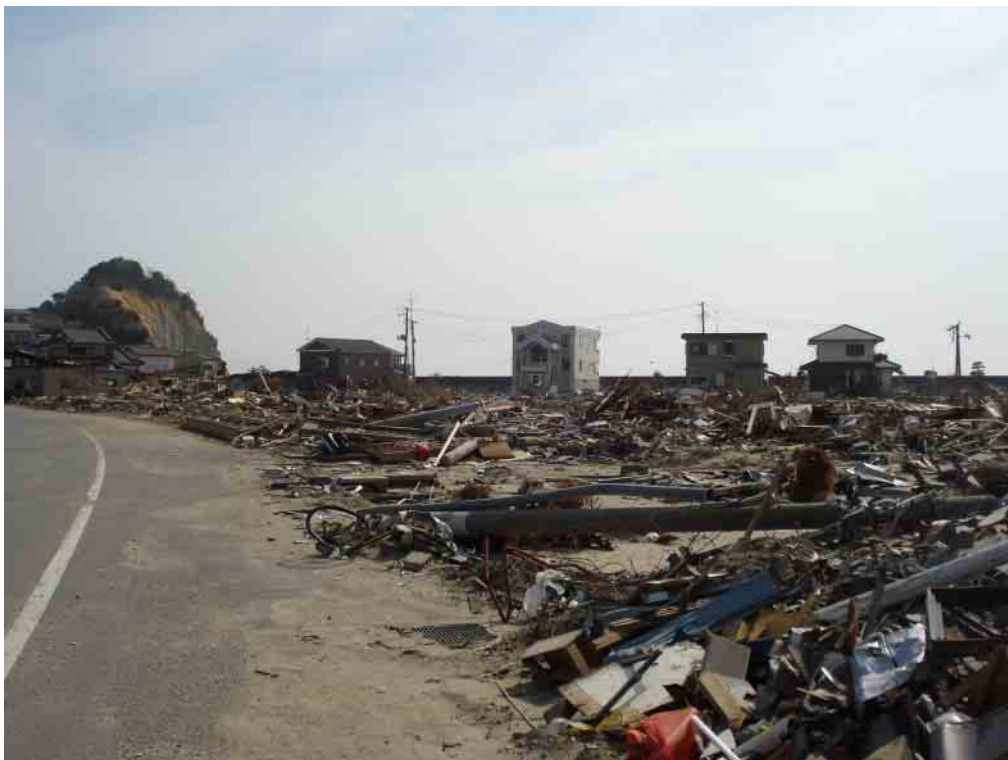
図-2a いわき市__大久川河口右岸周辺（陸側から海側を臨む）
